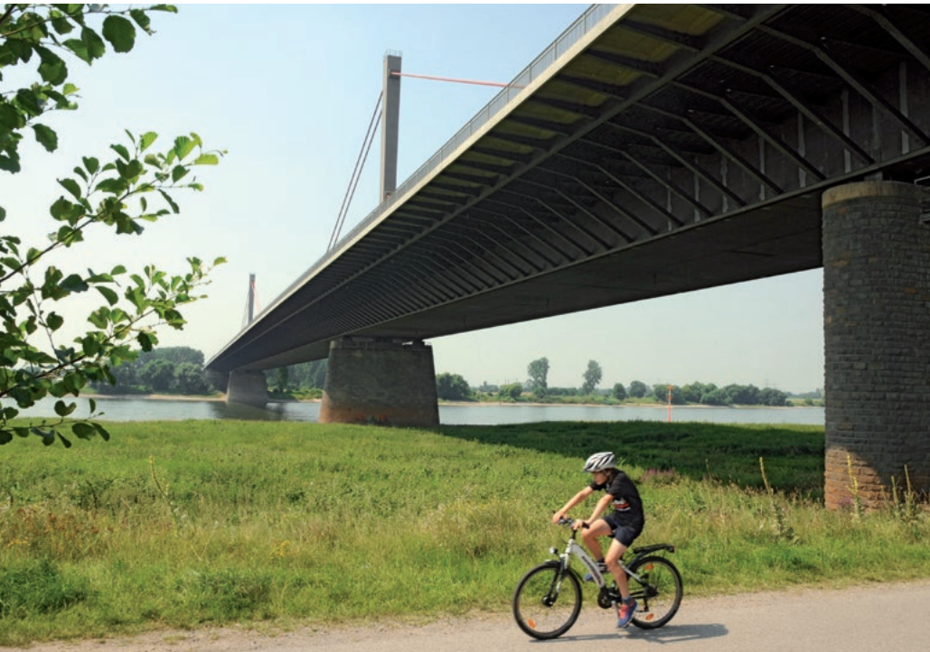
1965 in Betrieb genommen und inzwischen marode: Die 700 Meter lange Rheinbrücke auf der A1 bei Leverkusen ist die meistbefahrene Brücke in NRW. (Foto: Horst Ossinger dpa)
