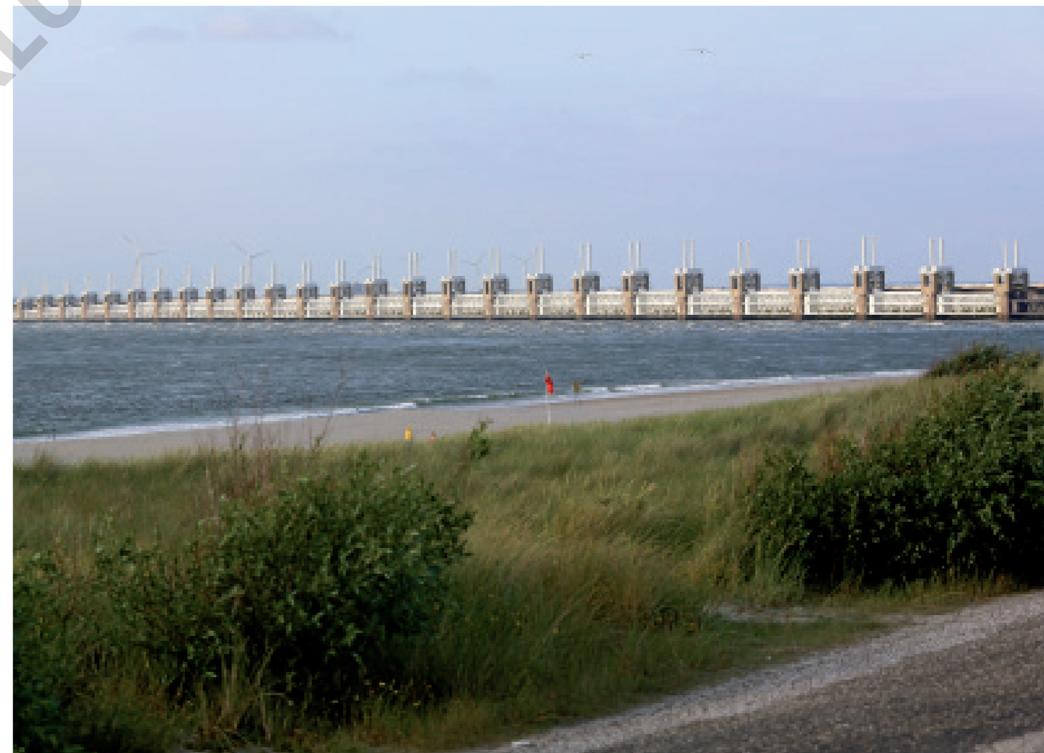
Das Oosterschelde-Sturmflutwehr ist Teil der Deltawerke, die hauptsächlich in der niederländischen Provinz Zeeland vor Sturmfluten und Hochwasser schützen sollen. Die gesamte Sperranlage ist neun Kilometer lang.
