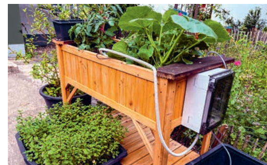
Automatische Bewässerungsanlage an einem Hochbeet, Foto: Christian Rall
